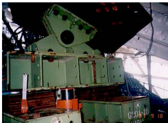
屋根鉄骨の仮設支持部 （オレンジ色は油圧ジャッキ）
