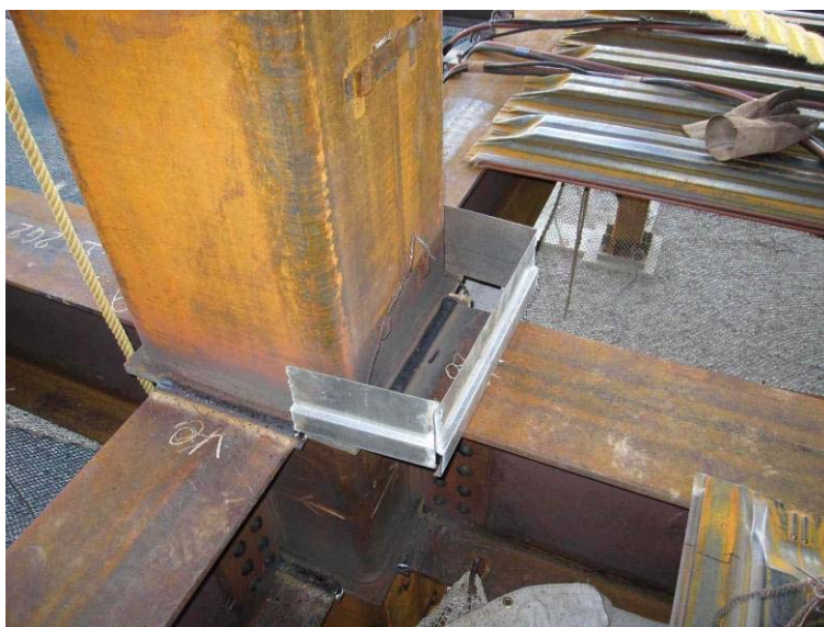
溶接部近傍のみを囲う防風装置の例
