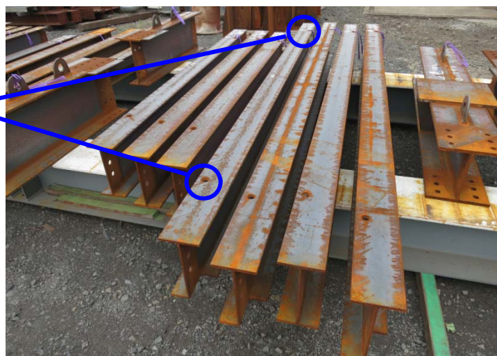
仮置きされた小梁
