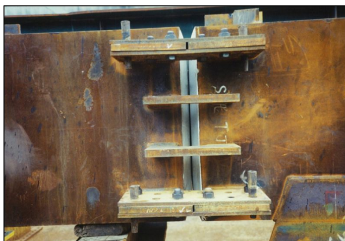
仮組時の現場溶接部精度の確認
