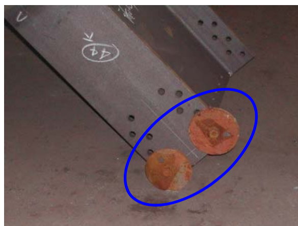
鋼板の残材（貫通孔を抜いた残材など）を利用した保護冶具
