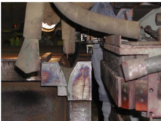
大電流サブマージアーク溶接
