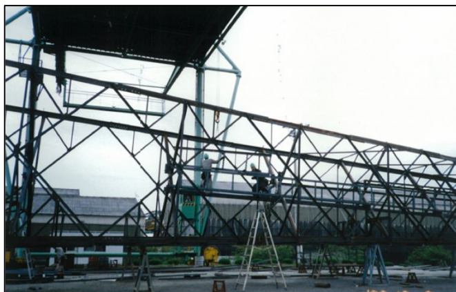
送電鉄塔の仮組
