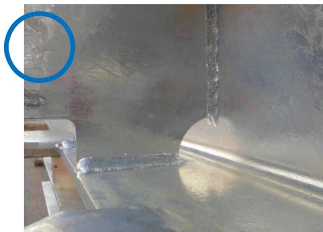
ただし、柱梁接合部のような地震時に大きな荷重を受ける部位は、載荷試験の結果からスカラップ形状ではなく、ノンスカラップ形状で円形孔にします。
