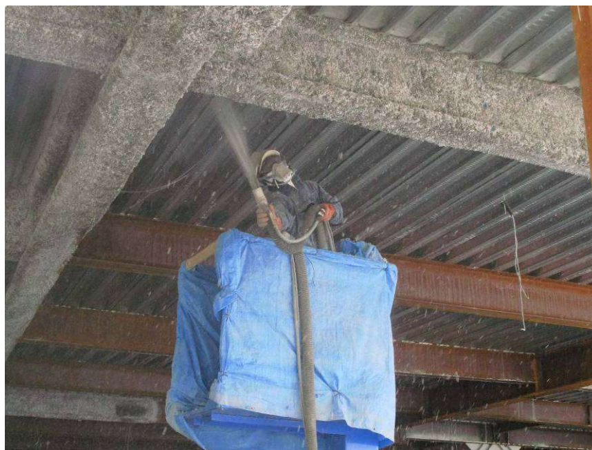
吹付けロックウール施工状況
