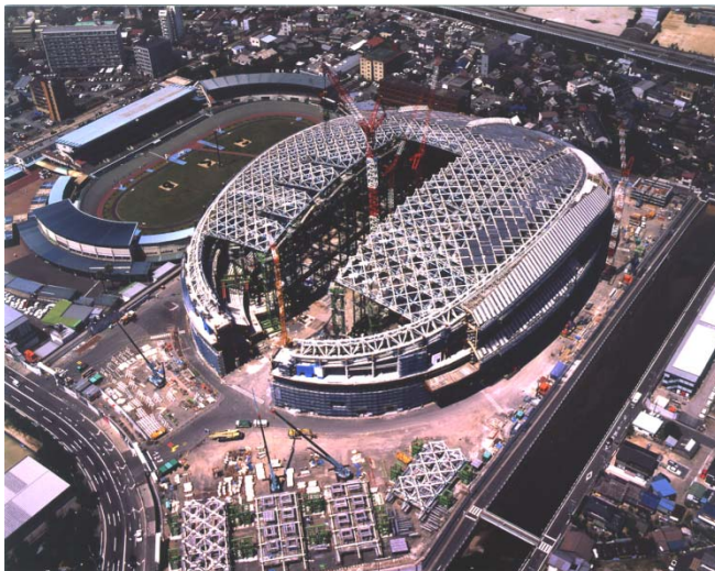
大空間建物の建方状況
