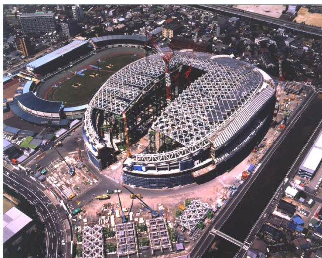
大空間建物の建方状況
