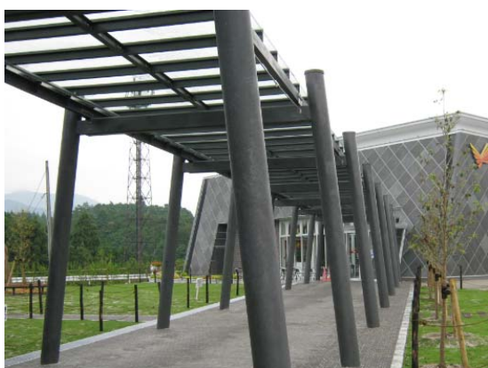
りん酸亜鉛処理施工例 3
