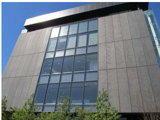
りん酸亜鉛処理施工例 1
