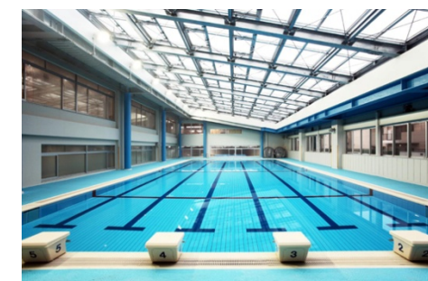
トップライト・自然通風 (プール)
