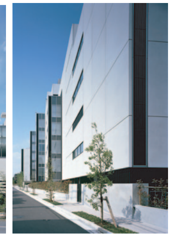
南西側外装(給気口)
