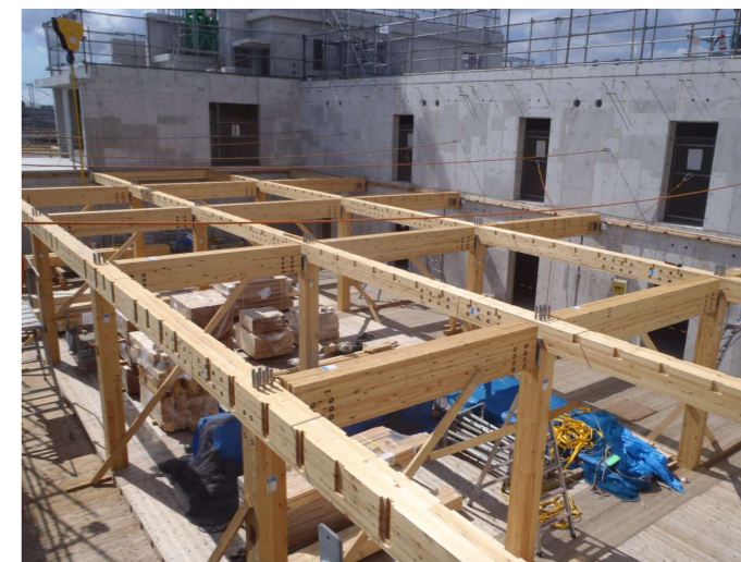
RC部「ダンベル型」+木造部 施工写真
