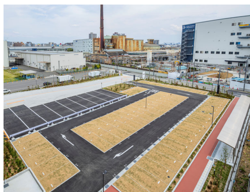
駐車駐輪場 外構写真
