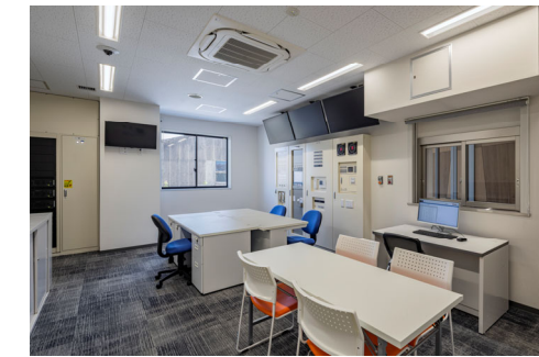
防災センター写真
