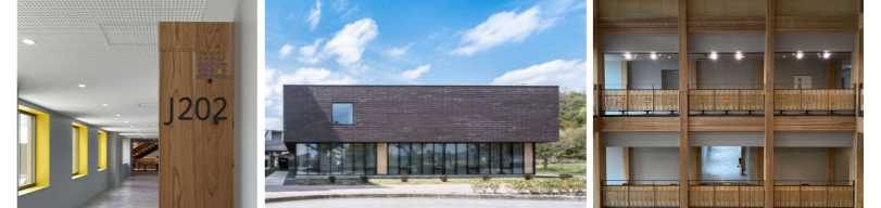
躯体試験材を再利用した県産スギサイン リサイクル材を利用した外壁仕上げ 別産竹細工技術を用いた吹抜手摺
