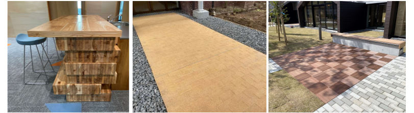
躯体試験材を再利用したカウンター 間伐材を再利用した木ブロック舗装 廃プラスチックを再利用した外構舗装材
