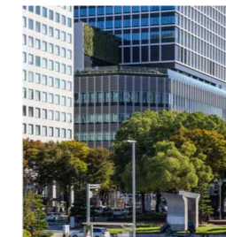
久屋大通から見た壁面緑化
