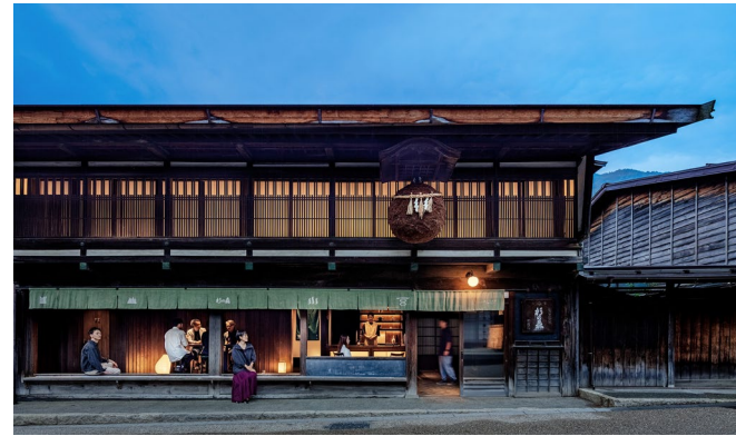
既存活用された旧中山道の歳吉屋ファサード
