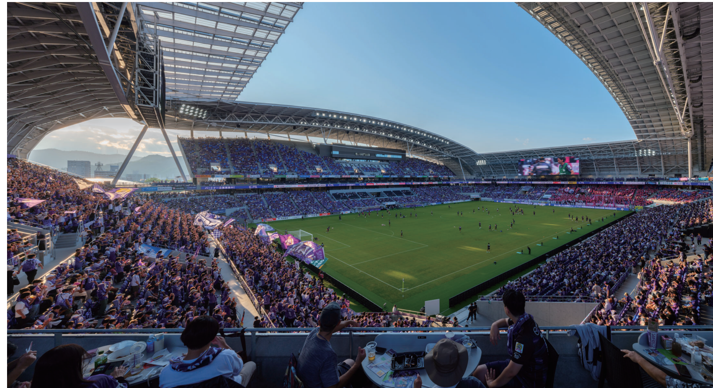
スタジアム4階、バラエティシートから見る。約28,500人収容。客席を覆う屋根は張弦キールガーターを採用し、南北方向約135mを支える。
