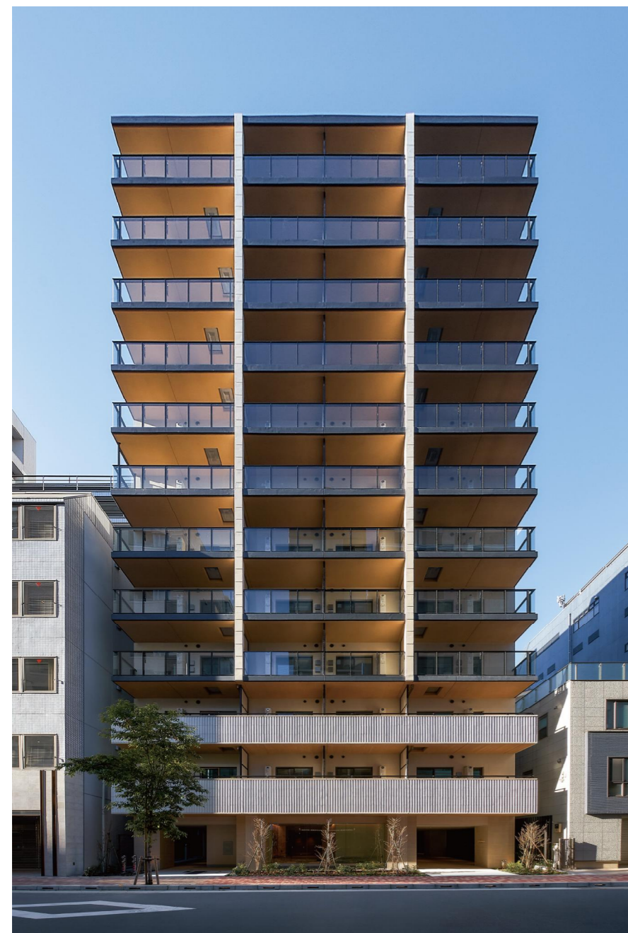
建物南面外観
