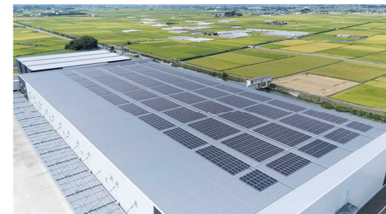
太陽光パネル
