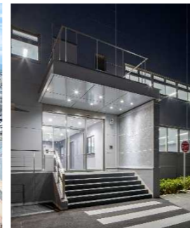
東面エントランス
