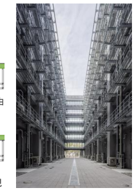
工学新棟 テクニカルバルコニー
