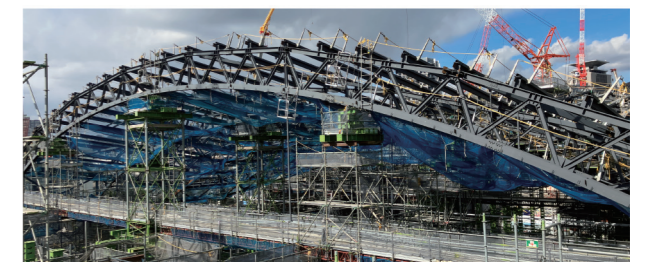
タイドアーチトラス施工状況
