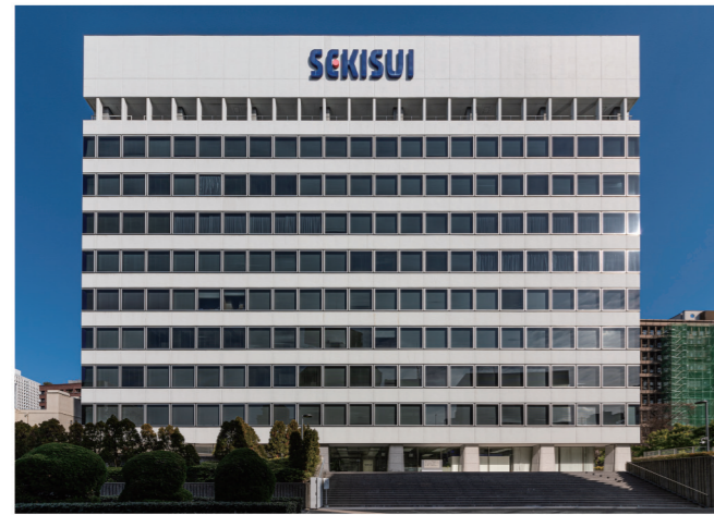
外観正面 (改修前)
