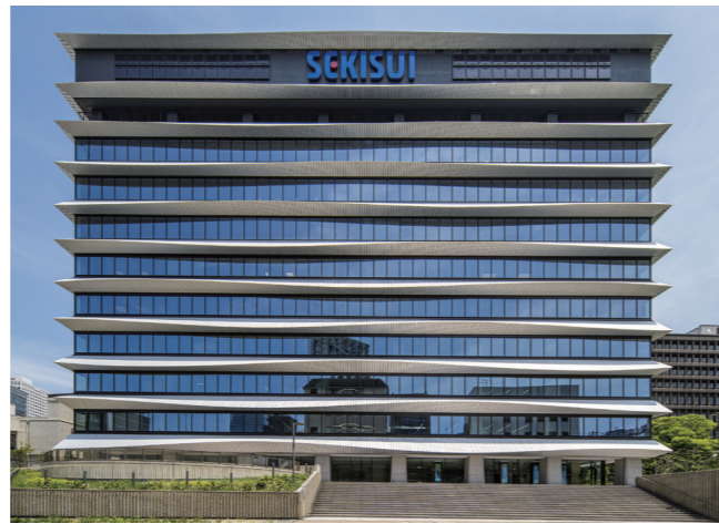
外観正面 (改修後)
