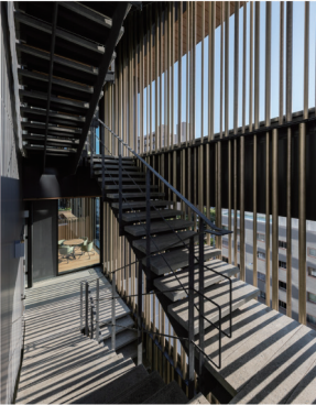
前面通りに面する外部階段
