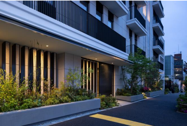
北側アプローチ外観
