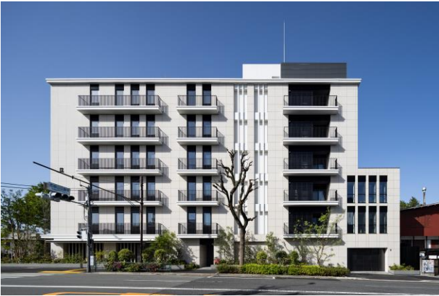
北側外観（通り側）
