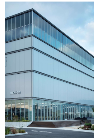
外壁：アルポリックパネル
