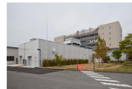
エネルギー棟と南側外観
