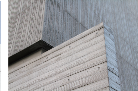
外装②杉板本実型枠仕上
