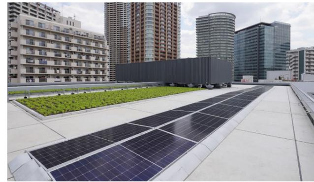
設置後の移動も可能な低重心置基礎架台方式の太陽光パネル
