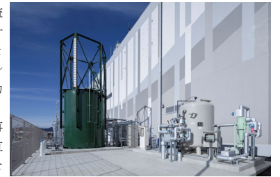
バイオガス発電
