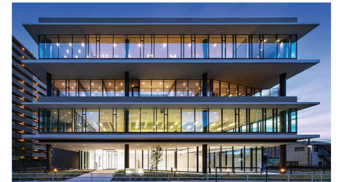
グラデーショナルに変化する照明色温度
