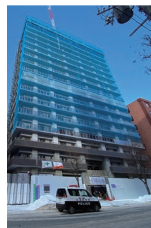
無足場による施工
