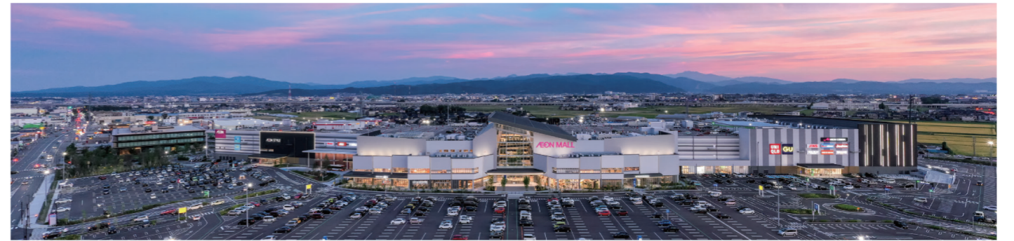
白山連峰を背景にして建つ（北側全景）
