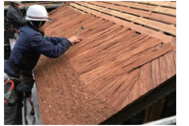
正門檜皮葺の施工風景
