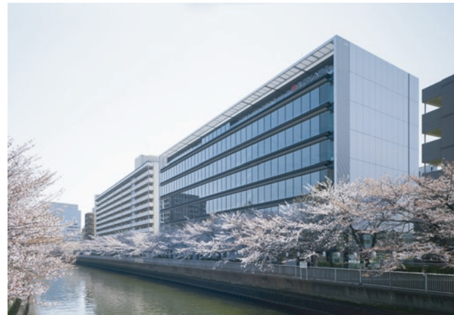
北側外観(巴橋より)
