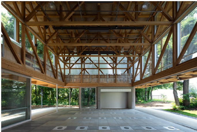
W-ANNEX 内観 1階建具一部開放
