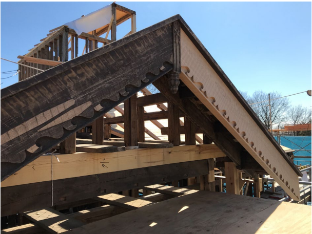
甚吉邸の破風板 左側：伝統技法による修理
