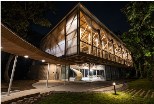
W-ANNEX 外観 ネオハーフティンバー
