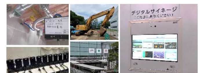
建設段階における取り組み
