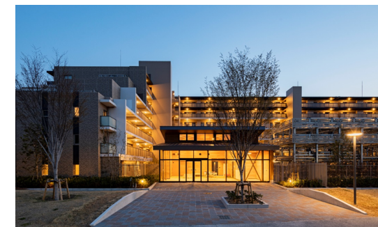
木造共用棟外観
