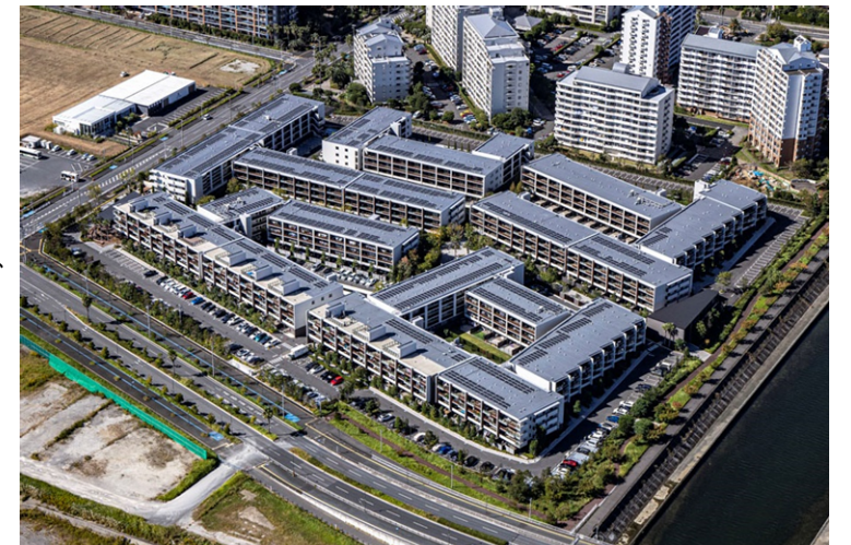
屋上太陽光パネル配置
