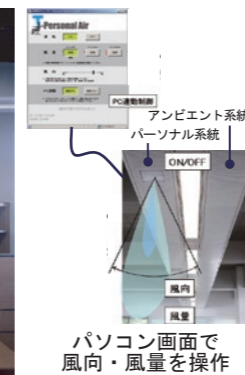
アンビエントシステム パーソナルシステム パソコン画面で 風向・風量を操作
