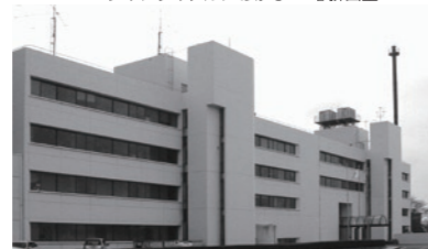
リニューアル前の外観 (1979年竣工)
