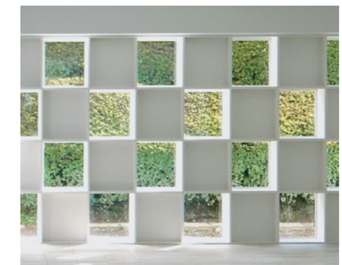
縦格子鋼板補強工法
