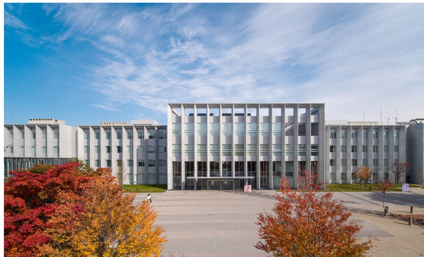
3mユニットを表現した外観
