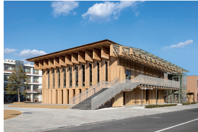
南西側外観. CLTパネル工法による木造校舎
