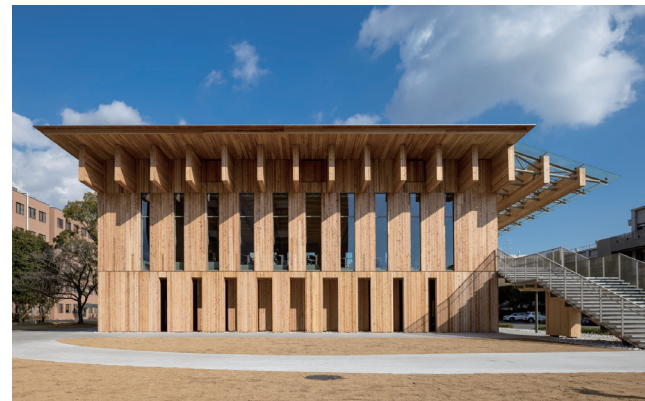
西側外観. 1, 2階で異なるCLTパネル配置を実現
