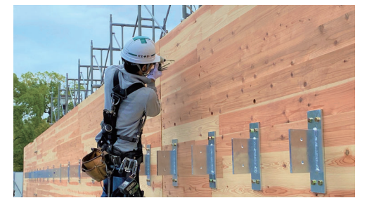
CLT大梁ジョイント・メタルレス構法施工状況
