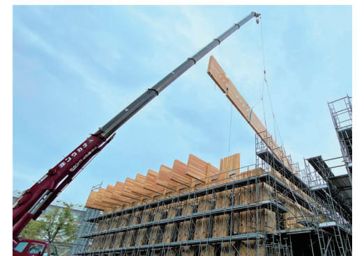
CLT大梁架設状況
