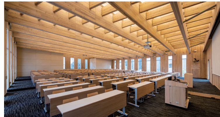
2階講義室. CLTパネル工法で国内最大級のスパン18mを実現
