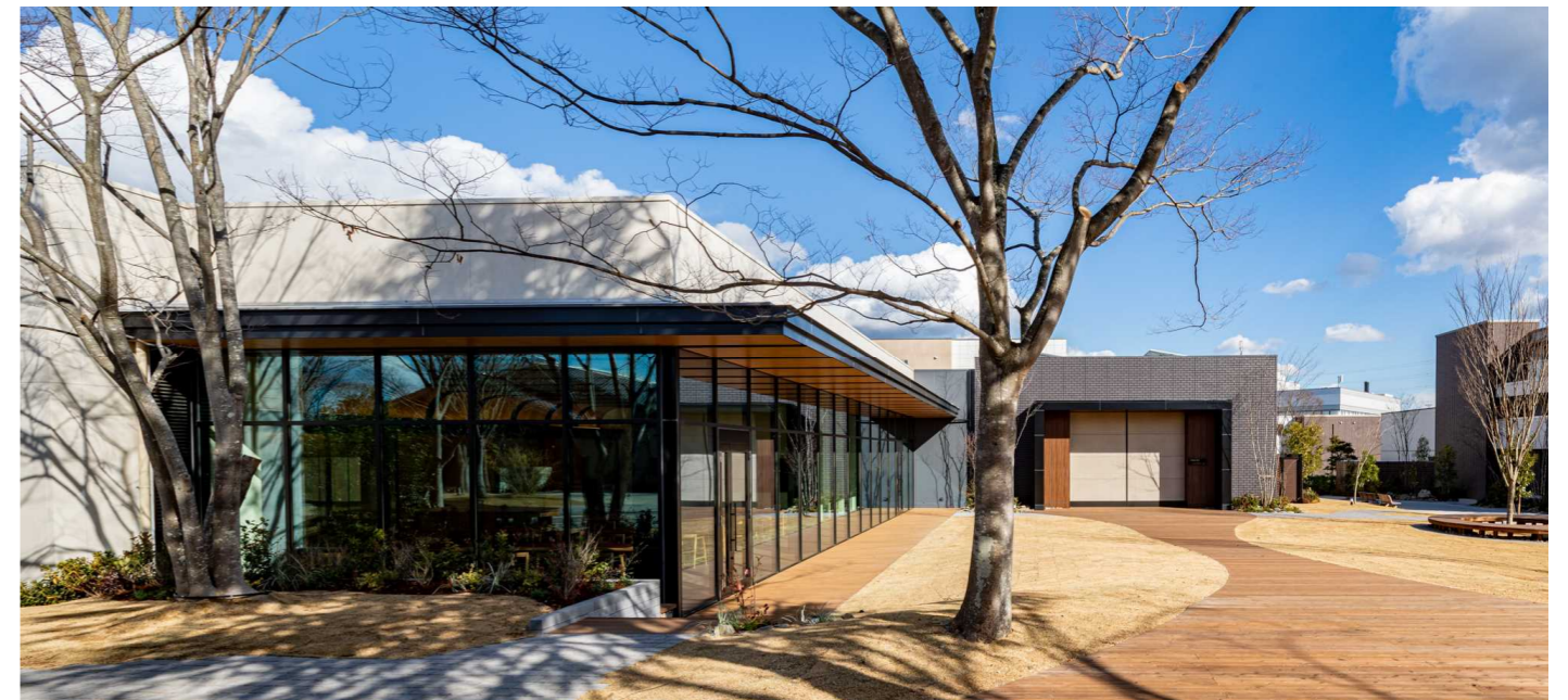
大開口部を覆う大庇（南面）
