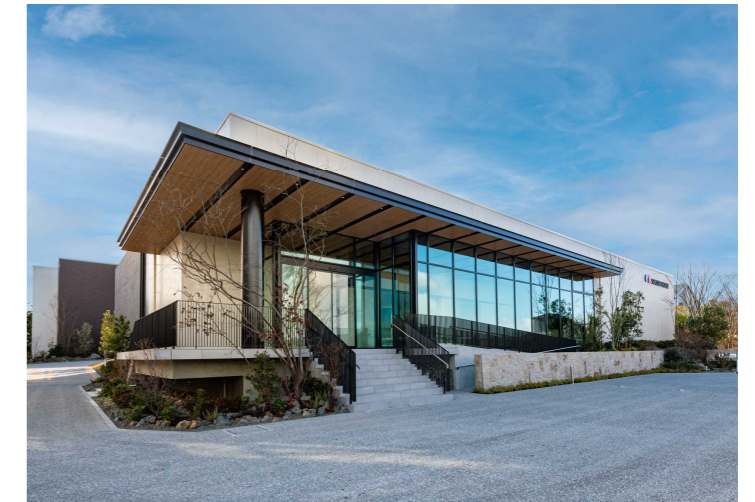
正面エントランスの大庇
