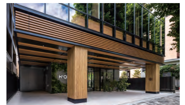
多摩産材スギ板貼りのピロティ柱
