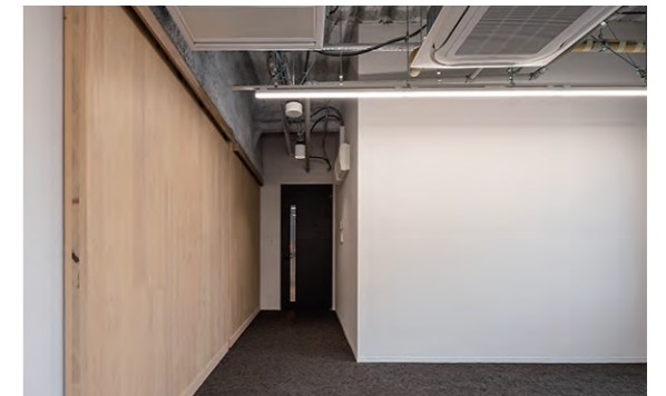
2分割した事務室内のCLT耐震壁
