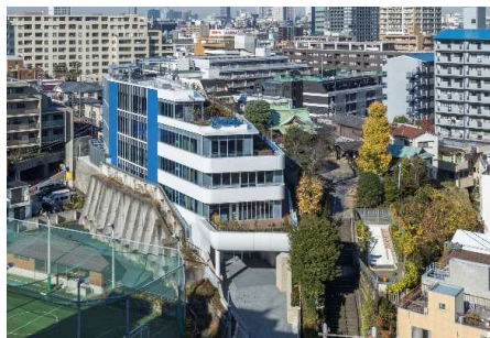
鳥瞰写真 (建物正面側)
