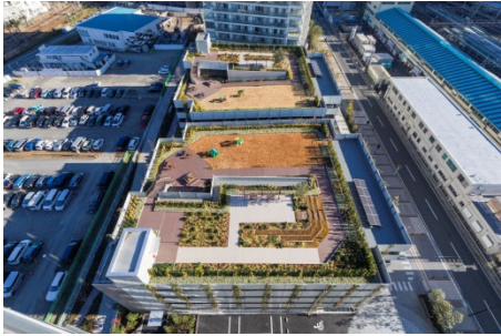
駐車場棟太陽光パネル
