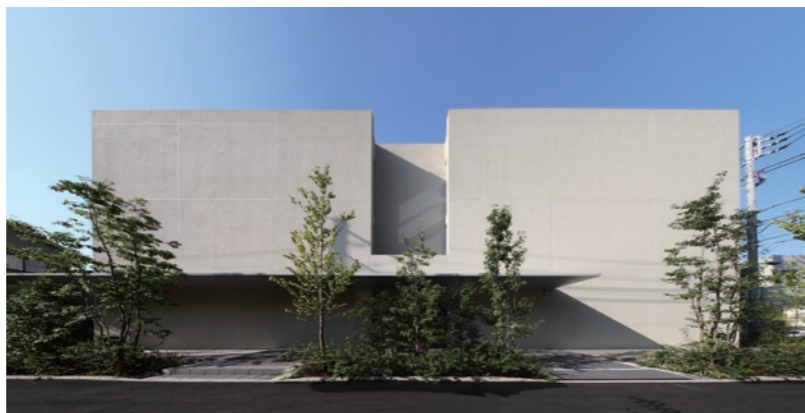
開口を道路・隣地に対し垂直方向に設け耐延焼性能を高めた妻側立面
