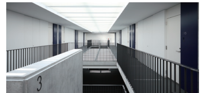
全面をトップライトとした3階ホール
