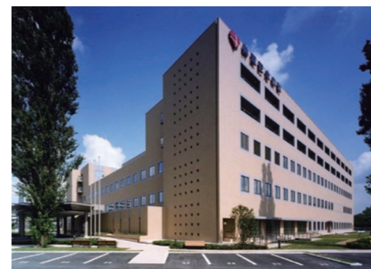
病棟部深いニッチ型バルコニー 南西側外観
