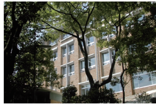
校舎は国分寺崖線に面して建つ※2
