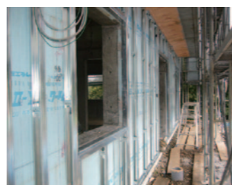
通気胴縁取付状況
