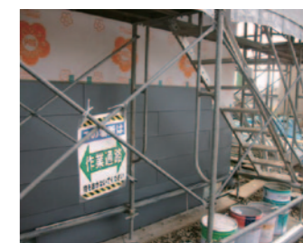
外壁ガルバ鋼板工事
