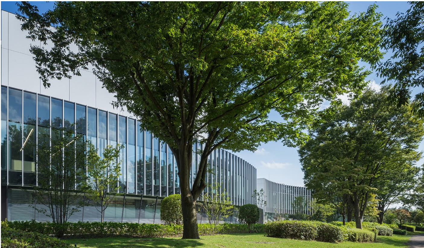
周辺環境と調和する西面ファサード（5号館・10号館）
