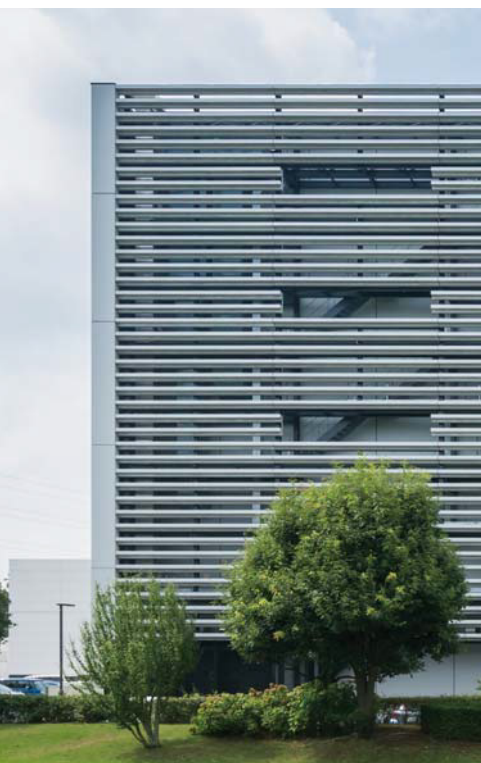
北面のメカニカルバルコニー（10号館）
