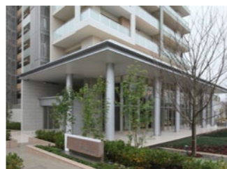
■ エントランス廻り
