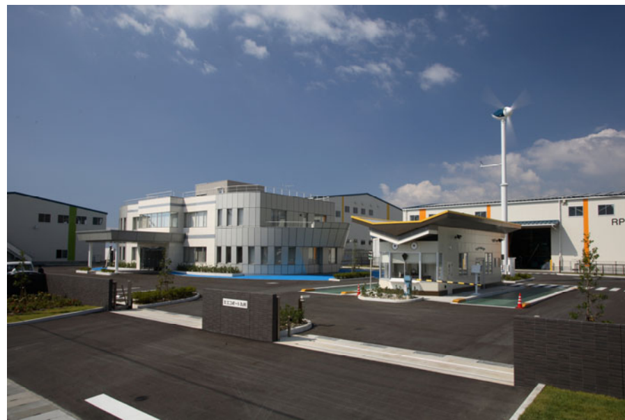
港を意識した船をデザインした事務所・後ろに風力発電設備を設置
