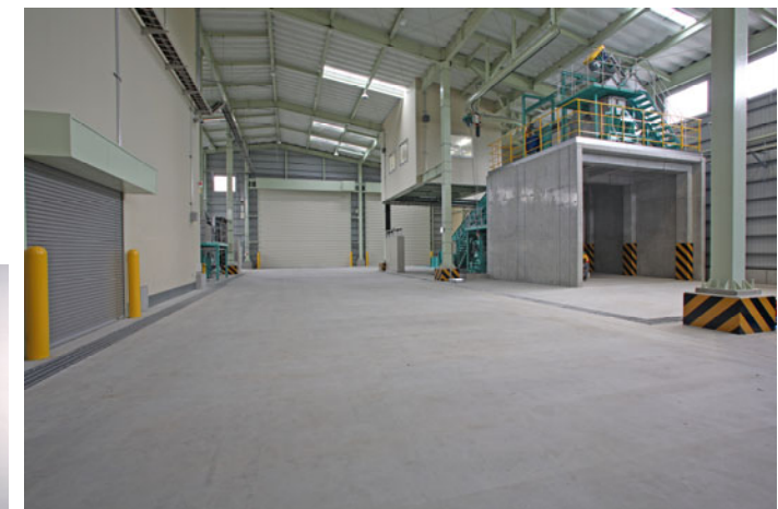
トップライト・ハイサイドを取り入れた明るい工場
